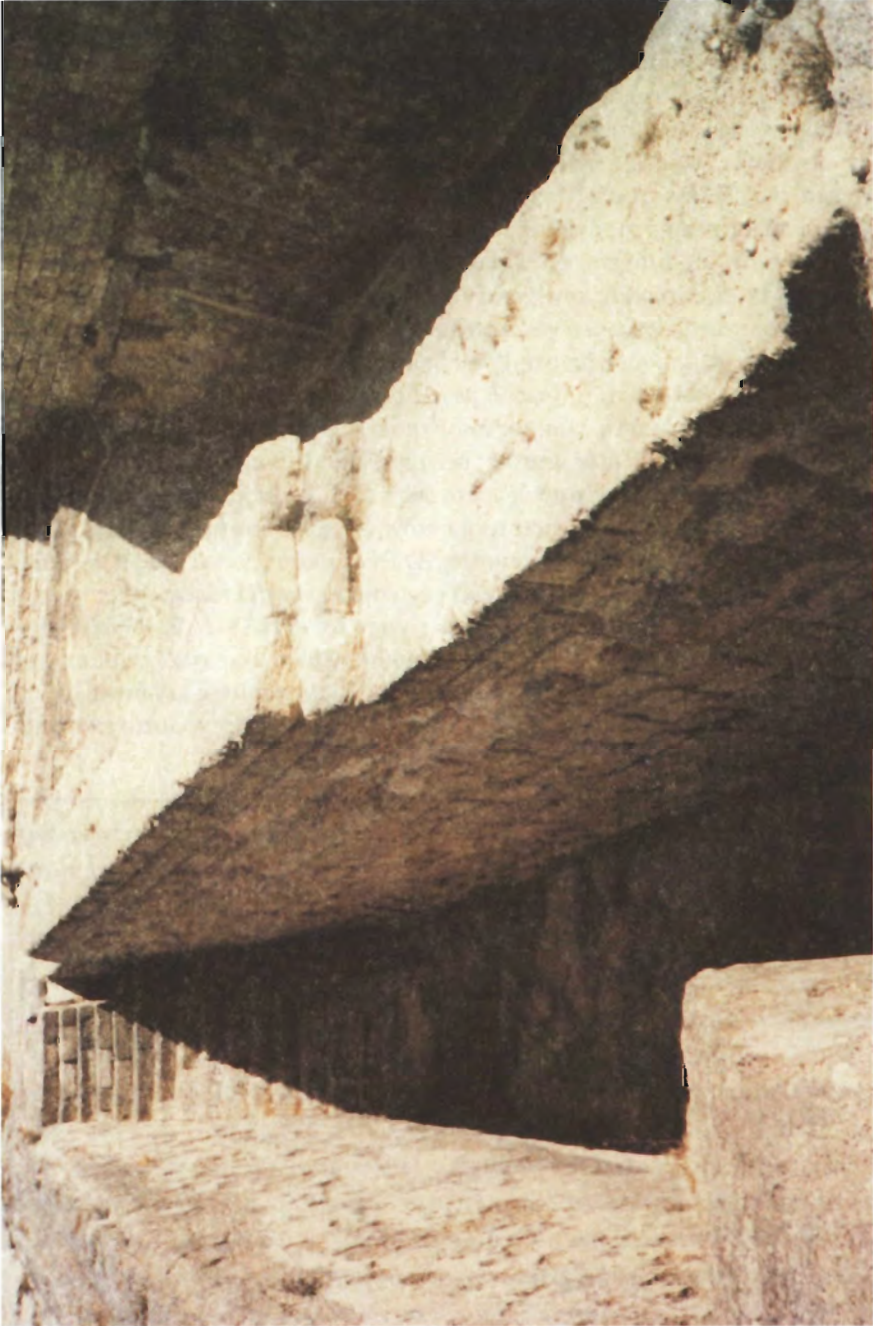
* Αποψη της αρχαίας ταμεντένιας δεξαμενής Καμίφου. Ο παχὺς μανδρότοιχος στὸ μέσον εἶναι μεταγενέστερη προσθήκη. (Φωτογραφία Εὐστ. Εὐσταθιάδη.)
